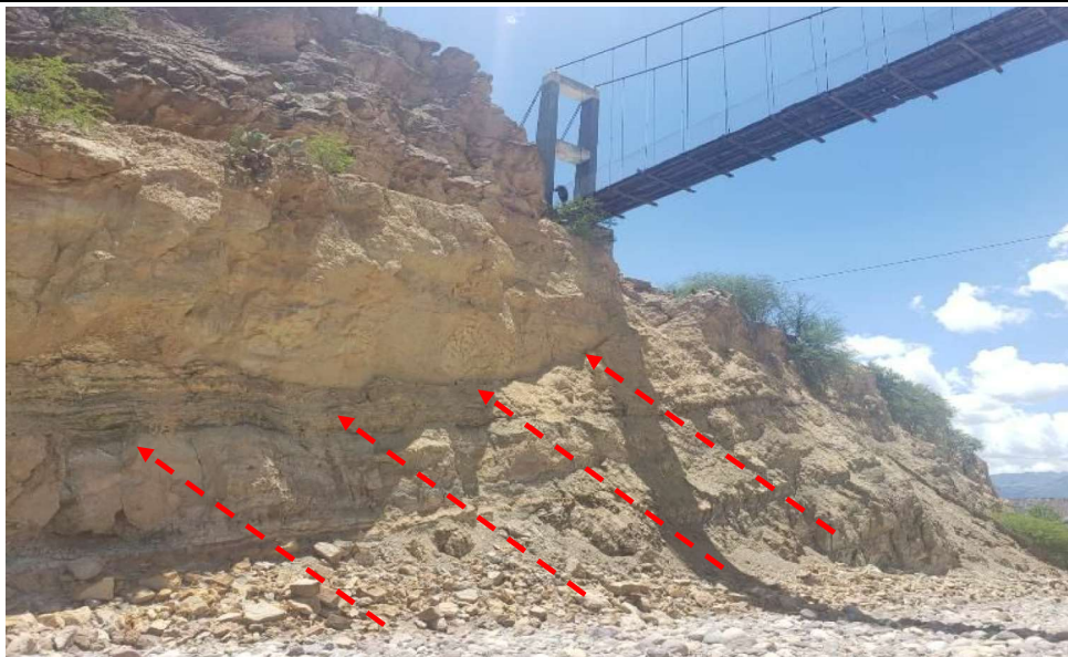
FIGURA 1. PUENTE PEATONAL QUE CRUZA AL BARRIO HUARPA, A PUNTO DE COLAPSAR POR LA CRECIDA DEL RIO HUARPA EN EPOCAS DE MAXIMAS AVENIDAS (ENERO, FEBRERO, MARZO), UBICADO EN EL DISTRITO DE MARCAS, PROVINCIA DE ACOBAMBA-HUANCAVELICA.
