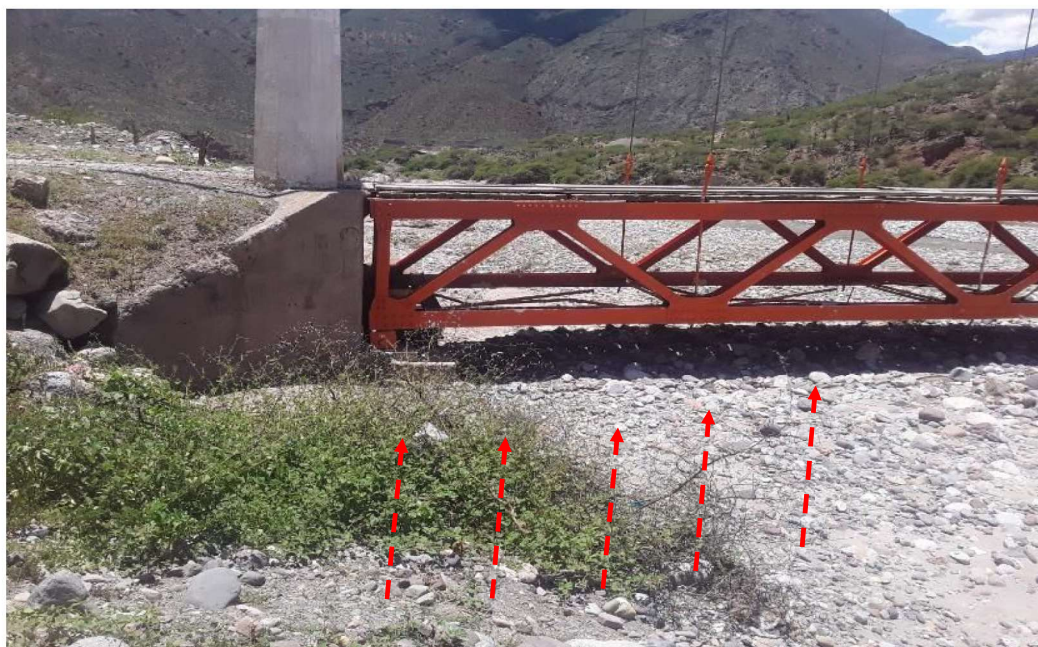
FIGURA 5. PUEBLO ALLCCOMACHAY A PUNTO DE COLAPSAR POR LA CRECIDA DEL RIO HUARPA, UBICADO EN EL BARRIO DE TINKUY, DISTRITO DE MARCAS, PROVINCIA DE ACOBAMBA-HUANCAVELICA.
